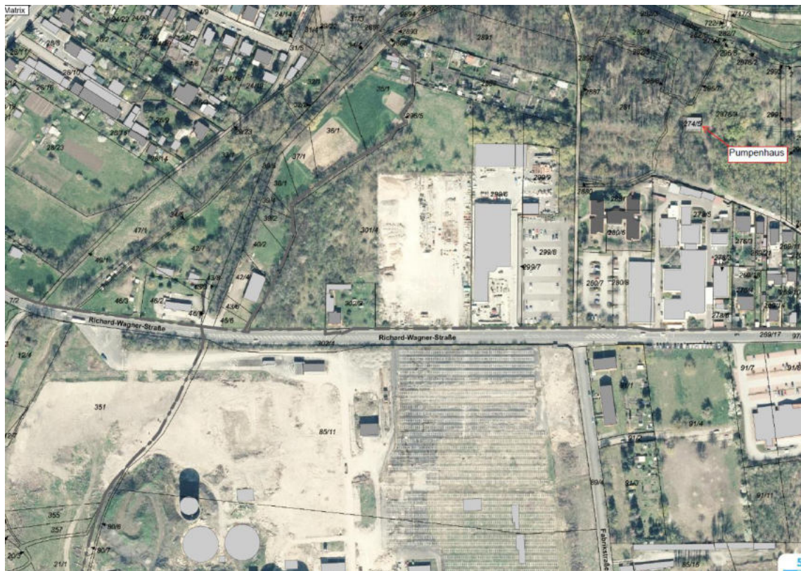
Abbildung 46: Kompensationsmaßnahme M 4: ehemaliges Pumpenhaus © Stadt Delitzsch
