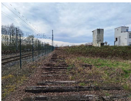
Abbildung 30: TF12, Blick nach Westen
