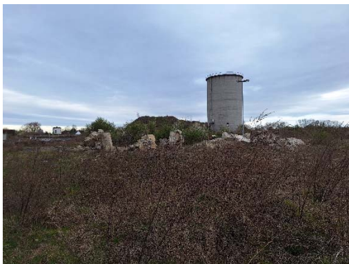
Abbildung 25: TF8, Blick nach Westen
