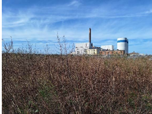
Abbildung 10: TF3, Blick nach Westen
