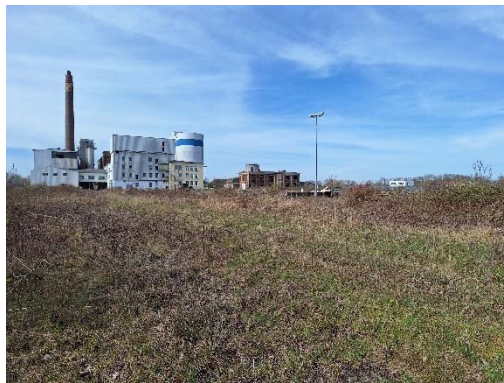
Abbildung 18: TF5, Blick nach Westen
