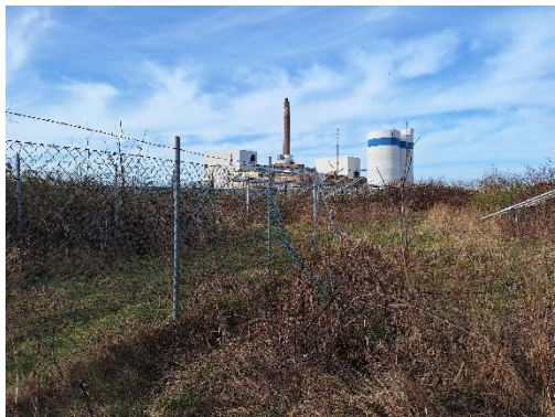
Abbildung 6: TF2, Blick nach Westen
