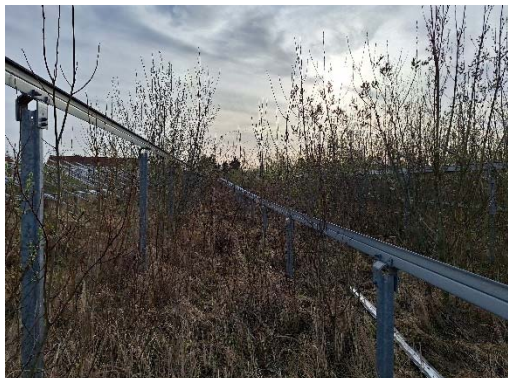
Abbildung 5: TF2, Blick nach Osten
