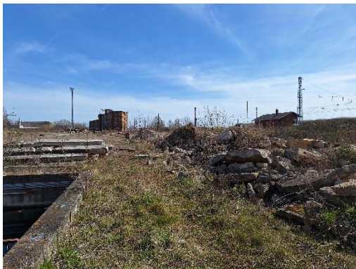
Abbildung 17: TF5, Blick nach Osten
