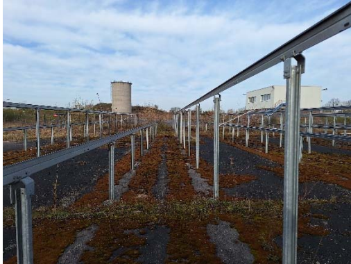
Abbildung 1: TF1, Blick nach Westen
