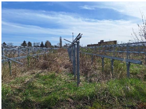
Abbildung 13: TF3, Blick nach Osten
