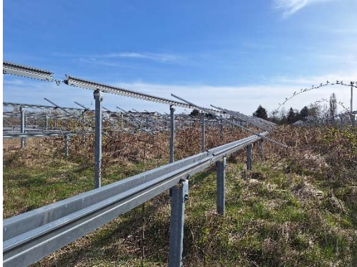
Abbildung 9: TF3, Blick nach Osten
