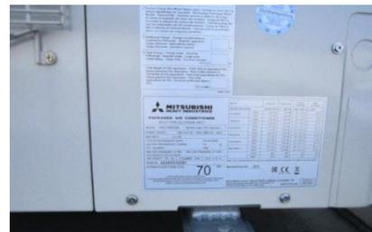
**Abb.1:** Ermittlung des Schallleistungspegels (LWA) der Lufttechnik eines bestehenden Verbrauchermarktes aus: goritzka akustik, Bericht 5207 V1.0 vom 26.09.2019
